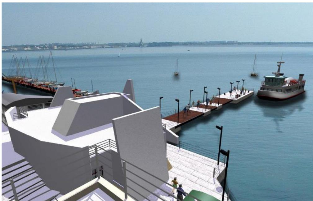
Il progetto del pontile di Cimino prevede: la rifunzionalizzazione della banchina esistente lungo l'affaccio sul mar Piccolo, con installazione di un pontile galleggiante per l'approdo delle idrovie, realizzazione di un centro servizi e biglietteria, area a verde. L'area antistante a parco Cimino è già interessata dal progetto di parcheggio di scambio che, con questo scalo, renderebbe la città raggiungibile via mare da quanti giungessero da est, oltre che con mezzi pubblici e biciclette.
